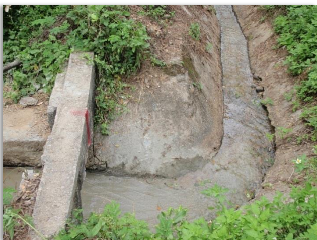
ด้านหนึ่งทดน้ำเข้าลำเหมืองส่งน้ำเข้าแปลงที่ทำกิน
