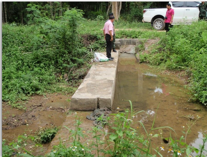
ฝายทดน้ำเพื่อแบ่งน้ำลงลำห้วย ๒ลำห้วยเท่าๆกัน หลังจากมีปัญหาในการปิดกั้นและตัดแปลงสันฝาย
