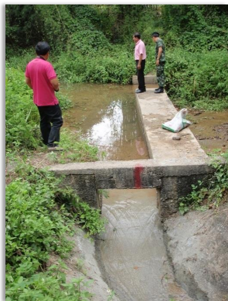
ฝายทดน้ำเพื่อแบ่งน้ำลงลำห้วย ๒ลำห้วยเท่าๆกัน หลังจากมีปัญหาในการปิดกั้นและตัดแปลงสันฝาย
