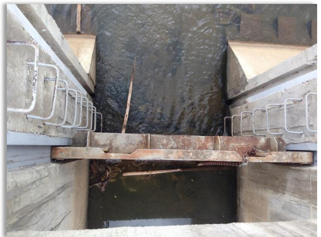
ประตุน้ำของฝาย ที่ถูกทุบและเจาะฐานที่กั้นน้ำ (ซ่อมในขั้นต้นแล้ว) เพื่อยกระดับน้ำเข้าลำห้วยสาขา
