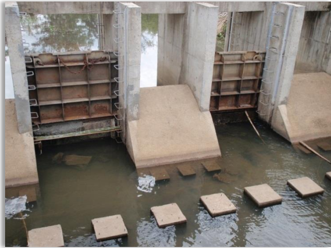
ประตุน้ำของฝาย ที่ถูกทุบและเจาะฐานที่กั้นน้ำ (ซ่อมในขั้นต้นแล้ว) เพื่อยกระดับน้ำเข้าลำห้วยสาขา
